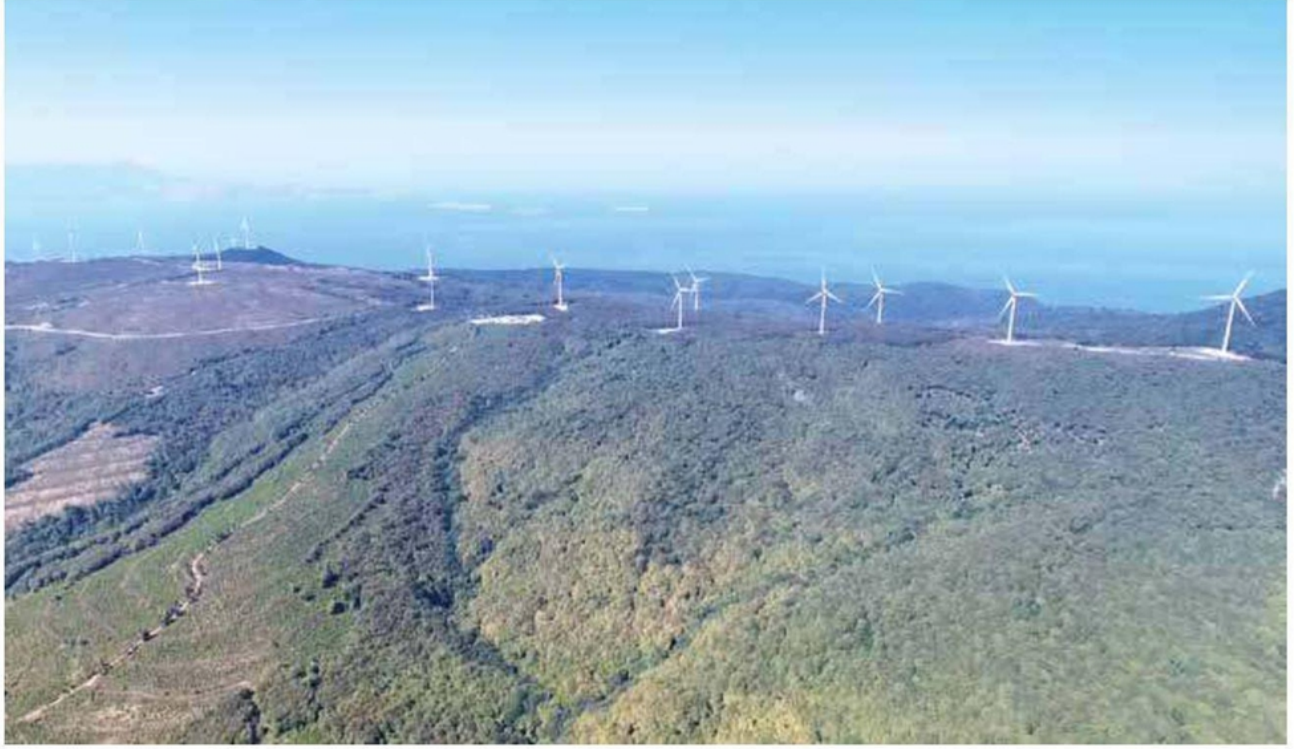
Bandırma Rüzgâr Enerji Santrali
